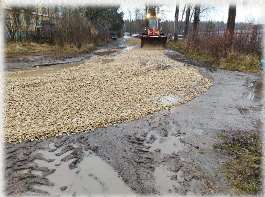
Ямочный ремонт деревня Митяево ул. Наро-Фоминская
