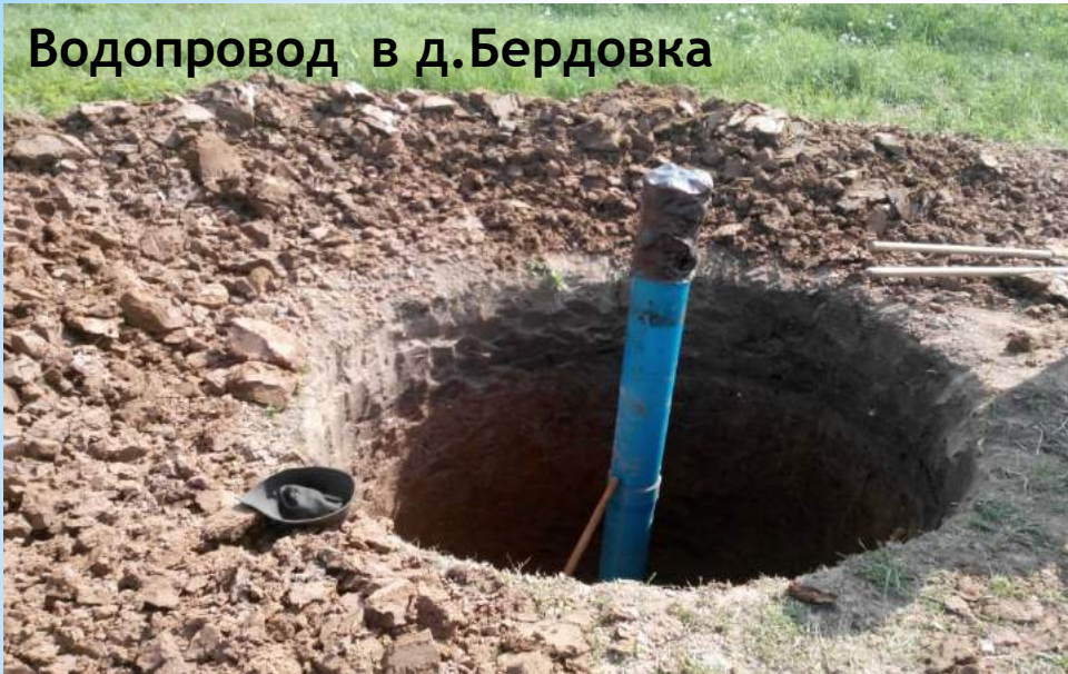
Установка пожарного гидранта в д.Совьяки
